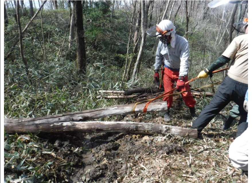
出口側の作業路上には、倒木を利用して橋を架ける
