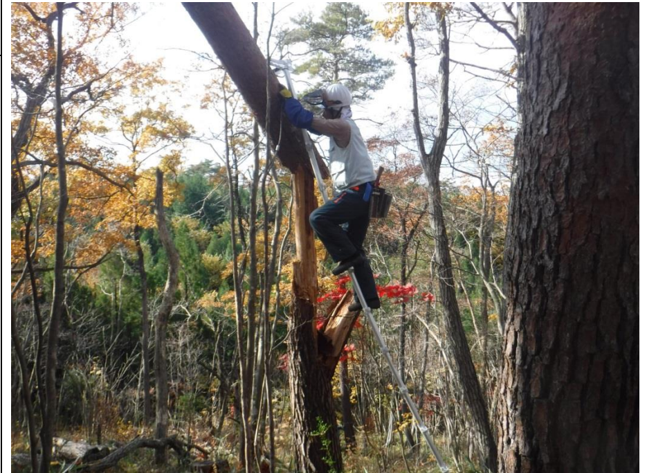
折れて乗っかっているところを引いて外しにかかります
