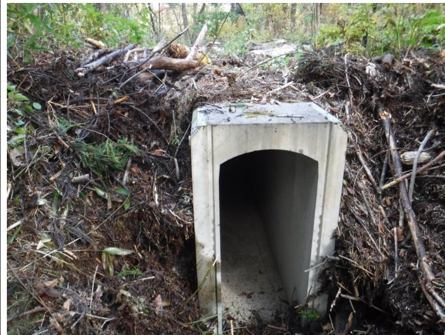
入口のゴミを取り除いたら、大きな断面が出現。
