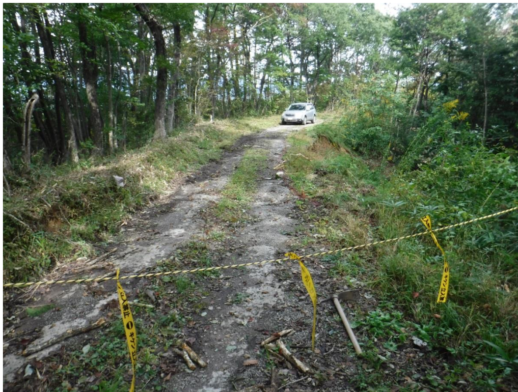
路肩が崩壊した箇所。通行禁止になっていました。画面左側を通行可能に。
