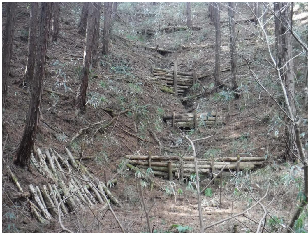
土砂留めの効果は？下層木の成長が予想より少ない→流失が続く？
