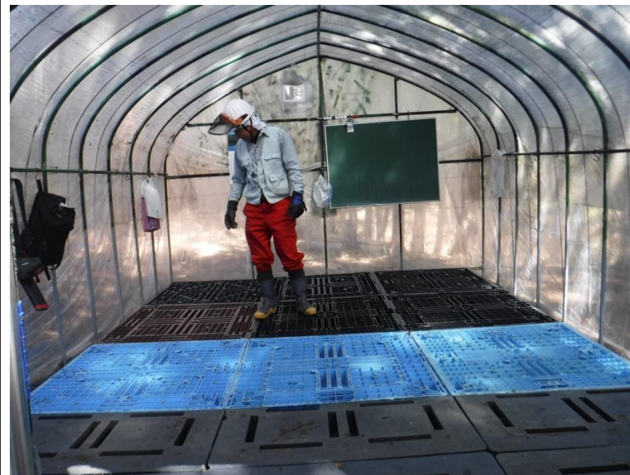
パレットを水平に敷き詰める
