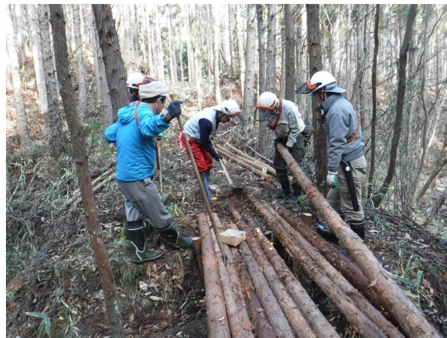
かがいを打ったり、地面を削ったりして安定させます
