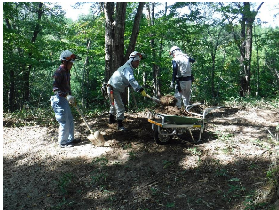
山になっている部分を削って
