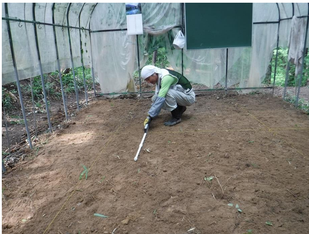
完成間近、道糸を張って水平に仕上げます
