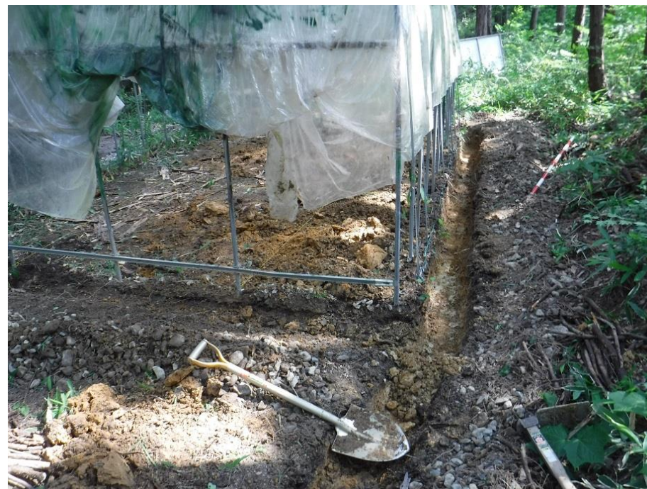
雨水溝を掘り下げます
