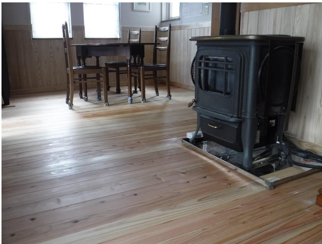
リビング・ダイニング（スギ）です。灯油ストーブを移動、煙突からの熱も有効利用。
