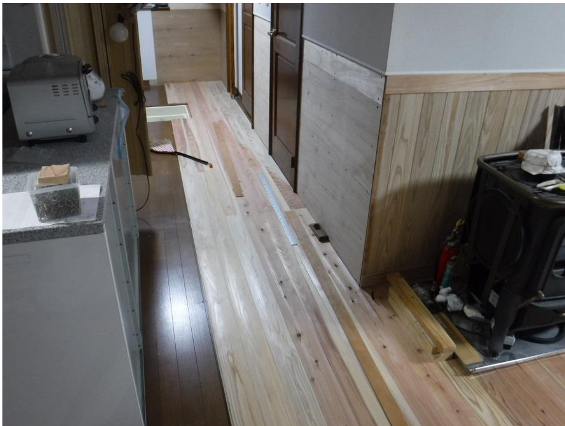
左手前は移動した調理台です。床下収納庫もかさ上げ。
