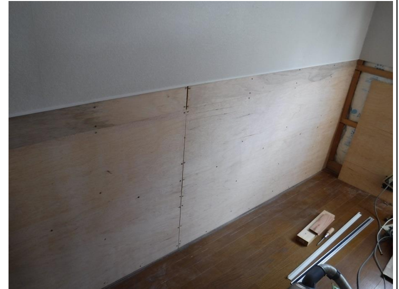
下地の ハ ニヤを張る。残す壁紙との取り合いに苦労する。何度も石膏ボードを削る。悲しき作業。
