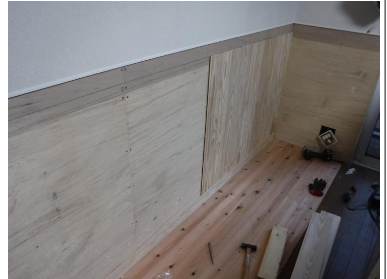
床を張り終え壁を張り始める。
