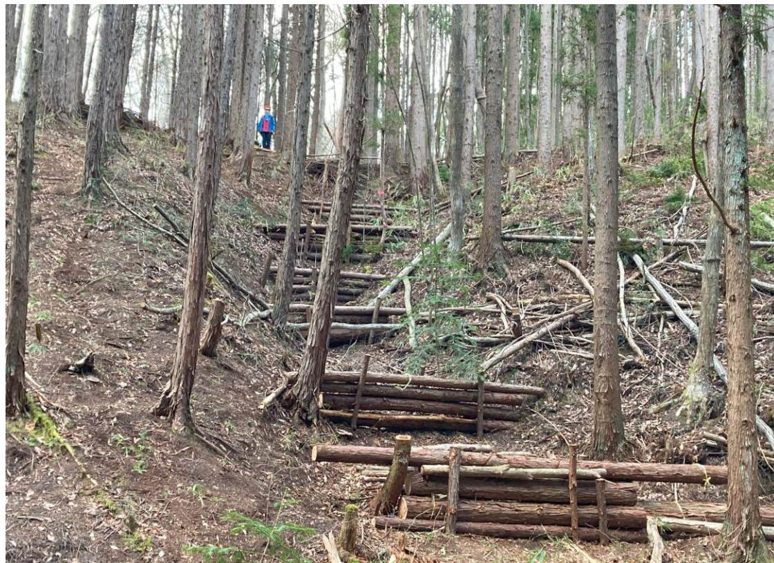
完成した土留めの柵 7 カ所
