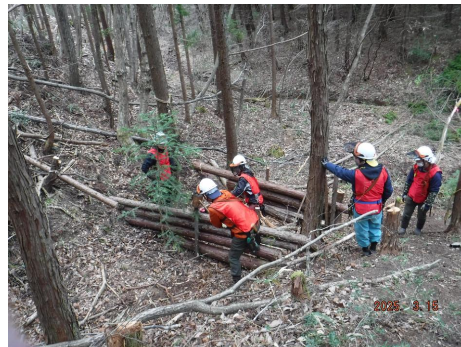
前後に立杭を打ち込んで丸太を積み上げていきます
