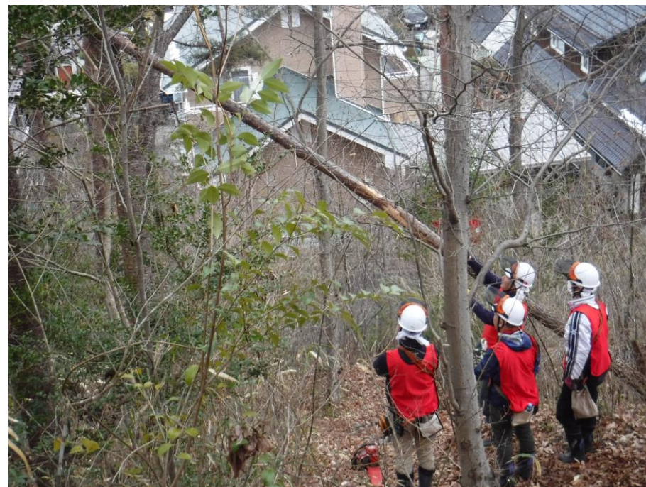
どの様にして撤去していくか、皆で意見を出し合います
