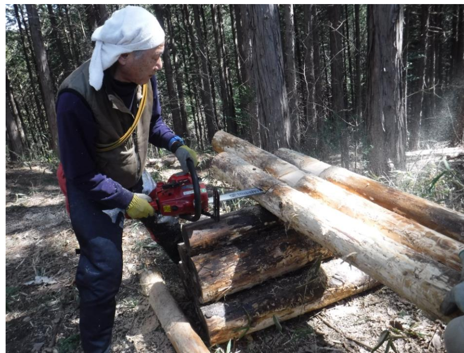
横木の固定座面を水平に切り欠きます
