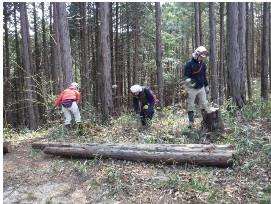
林地残材を引出し、設置場所を整地します
