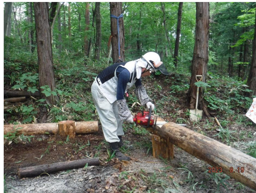
基礎に載る部分を水平に仕上げます
