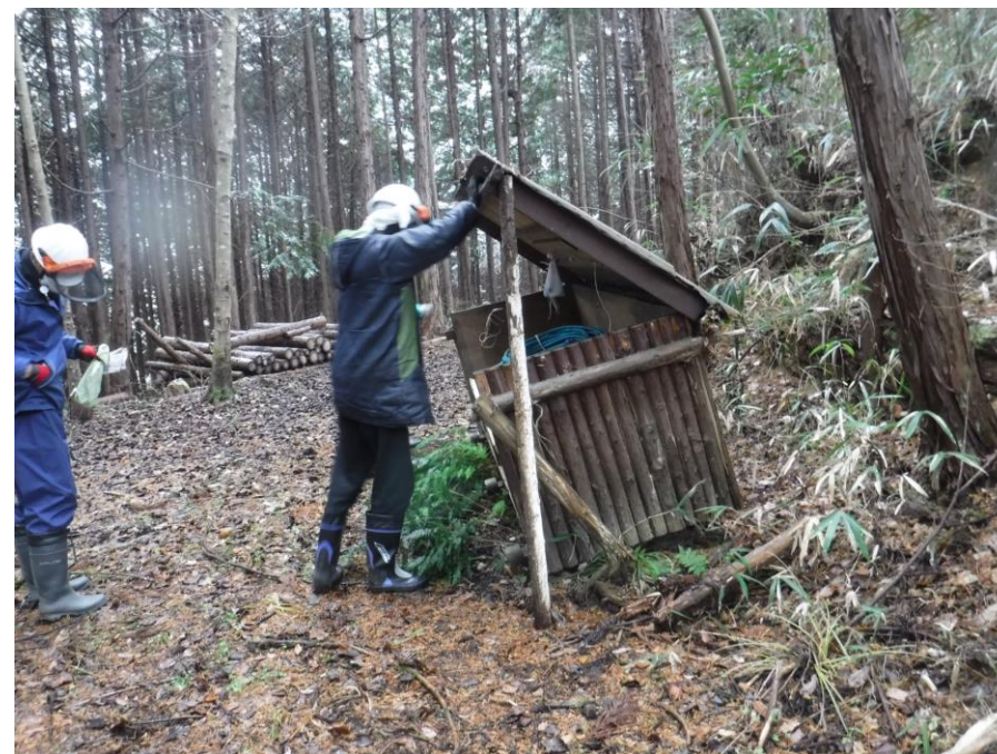
傾いた1号道具庫、築18年
